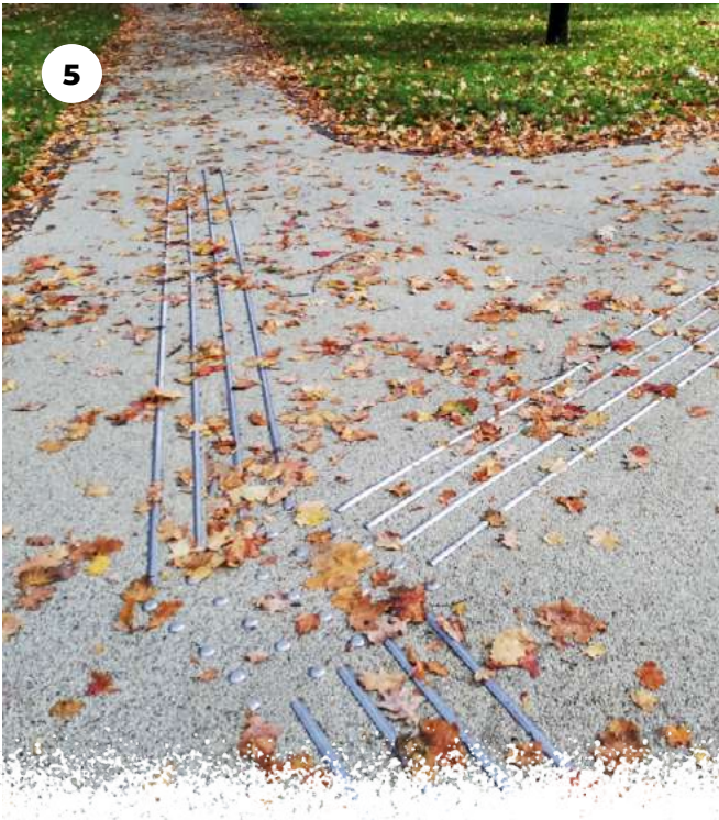
Зображення: 1 - проникна поверхня в лісопарку «Білогорща» у місті Львів (Україна); 2 - облаштування проникної дороги у місті Портленд (США); 3 - водопроникна доріжка у парку в місті Краків (Польща); 4 - дорога із дерев'яної бруківки у місті Піттсбург (США); 5 - інклюзивна проникна доріжка в Богуцькому парку у місті Катовіце (Польща)
